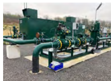
La première installation de rebours en Île-de-France à Mareuil-lès-Meaux, en Seine-et-Marne
