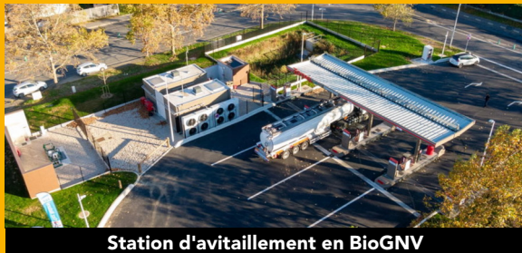
Station d'avitaillement en BioGNV
